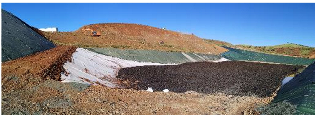
Figure 5 : Vue de la mise en exploitation alvéole F1
